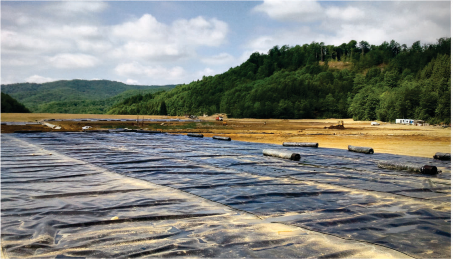
MATERIAL GEOTEXTIL 600/MP, GEOMEMBRANĂ 2 MM, ÎNCHIDERE MINĂ VALEA BOAJEI, MARAMUREȘ
